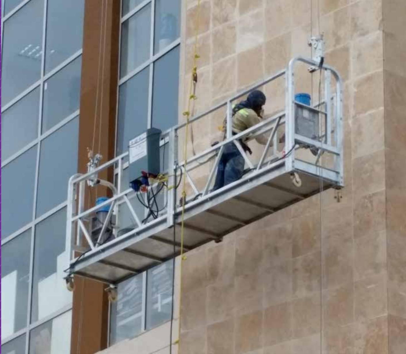
Andamio galvanizado con un diseño simple, ligera, fácil de operar, una capacidad de carga de 630 kgs. Sistema de seguridad con guayas independientes en caso de rotura de alguna de las guayas. Velocidad de elevación de 9 metros por minuto, ancho de trabajo de 2 metros hasta un máximo de 6 metros. Consta de dos motores eléctricos a 220 v/trifasicos.
