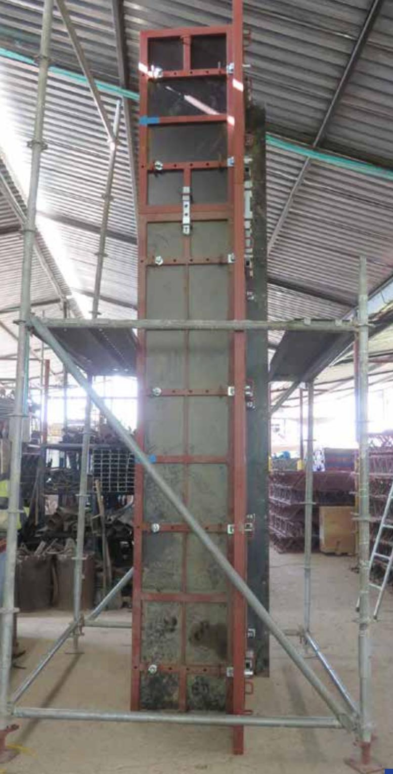
Formaleta modular tanto para columnas como para muros ligeras que permite montajes rápidos.
