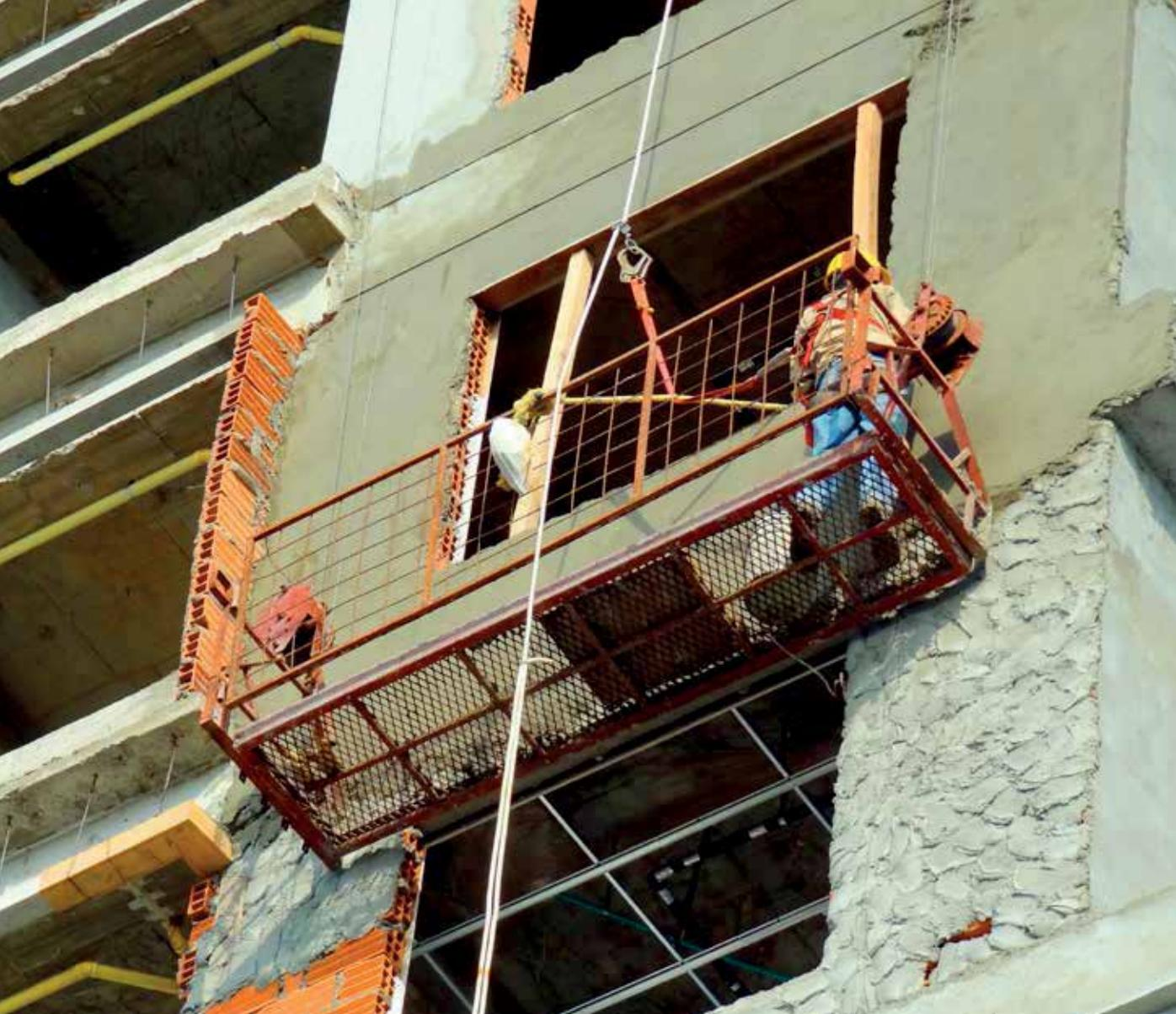
Andamio colgante tradicional, el cual consta de dos colgantes con guaya para 90 metros y una canasta o plataforma de trabajo de 3 metros de largo con su respectiva protección en la parte posterior para seguridad del trabajador. Permite unir una o más plataformas configurando longitudes de trabajo de 3, 6, 9 o más metros de acuerdo a la necesidad de la obra.
