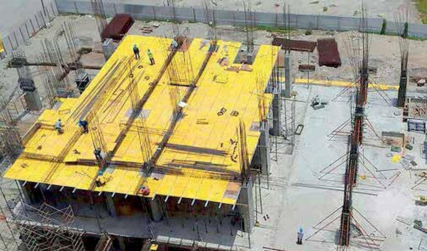
Sistema de encofrado recuperable que permite la realización de forjados de losa maciza o aligerada con la máxima sencillez y seguridad. Emplea como superficie encofrante tableros de 1 m de longitud.
